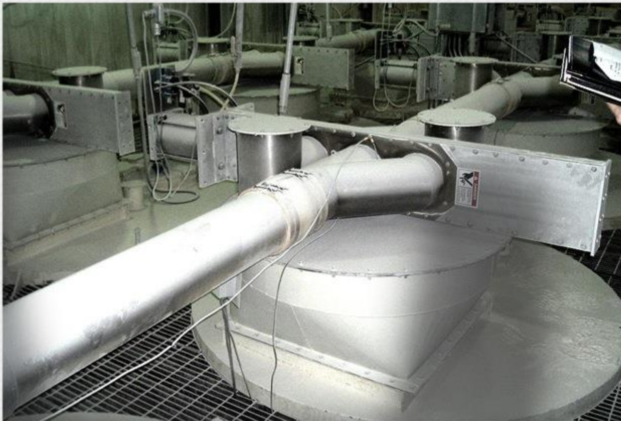
Дивертер 5" (127мм) над весовым ковшом работает с карбонатом кальция
