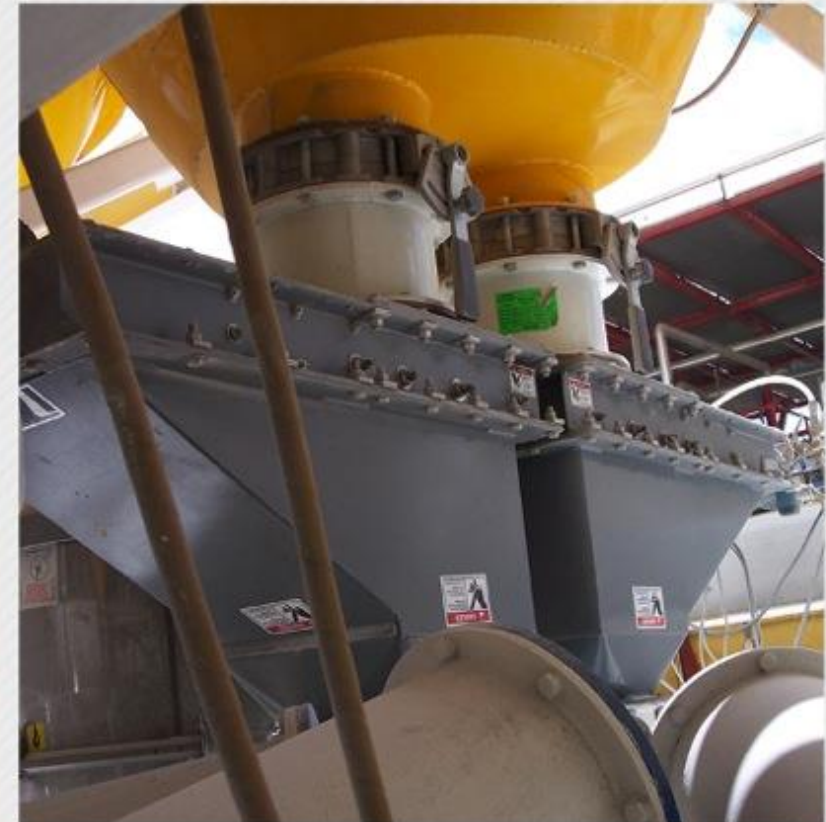
Задвижка 18" (457мм) работает с горячей золой
