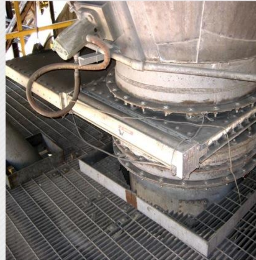
Задвижка 26" (660мм) с двумя цилиндрами
