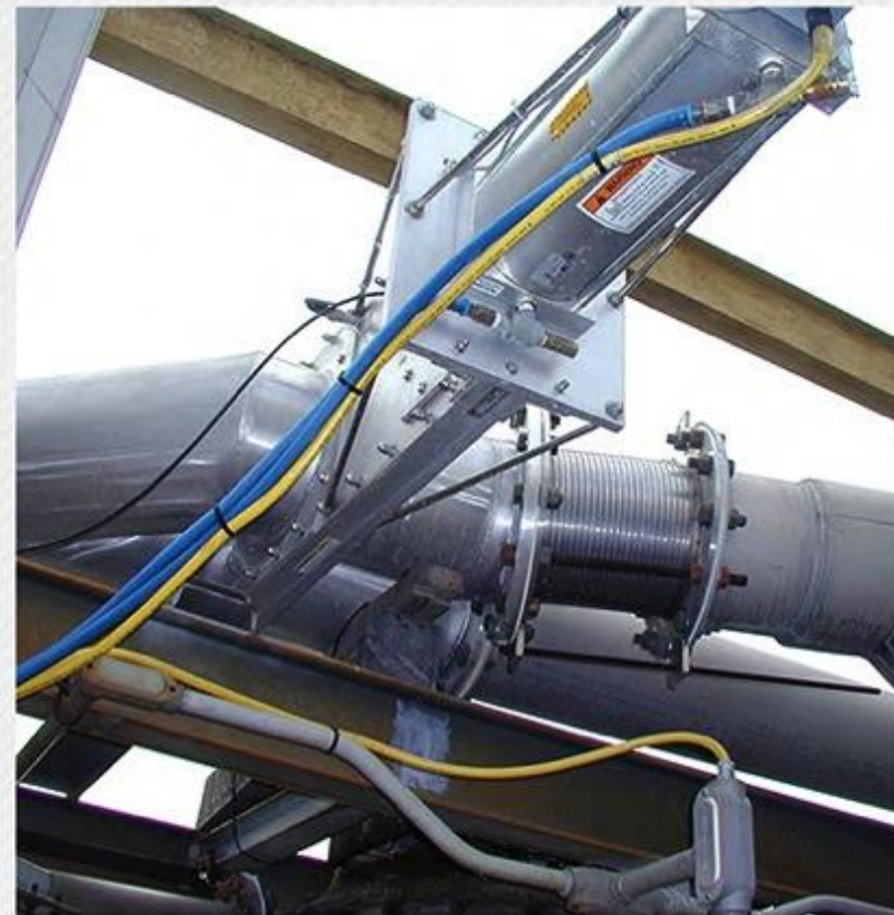
Задвижка 12" (305мм) работает с порошковой полиэтиленовой смолой
