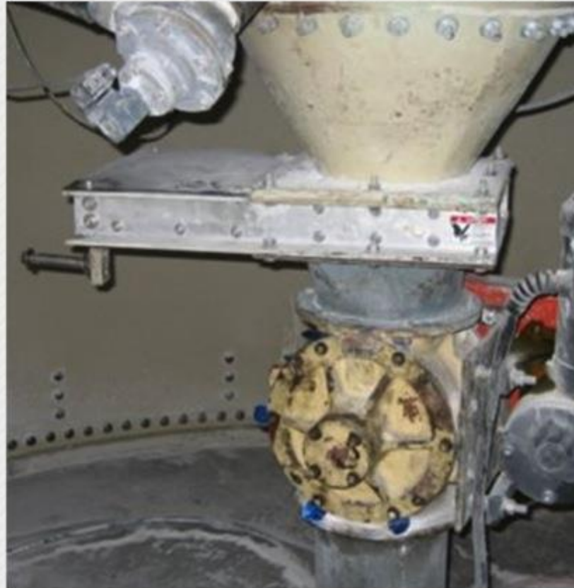
Задвижка 12" (305мм) установлена над шлюзовым питателем, транспортирующим соду
