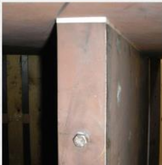
Заменяемые уплотнения заслонки уменьшают пыление
