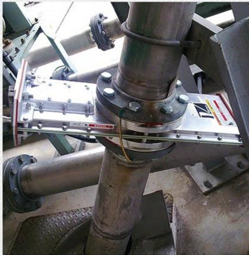
Задвижка с ручным приводом с фланцами по ANSI
