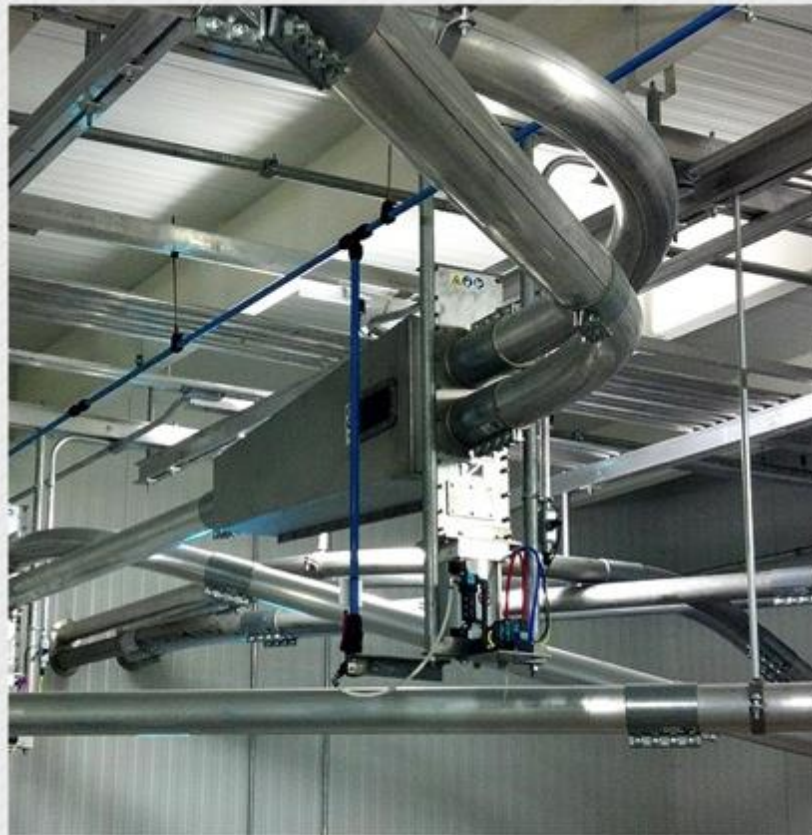
Дивертер 6" (152мм) работает с кофейными зернами
