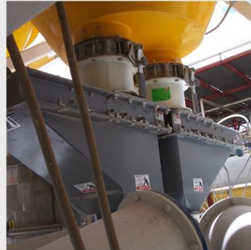
Задвижка 18" (457мм) работает с горячей золой
